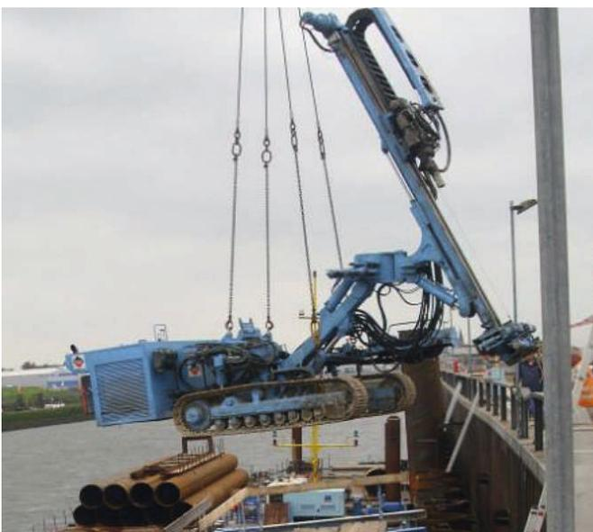
Bild 1: Einheben des Bohrgerätes auf dem wasserseitigem Hängegerüst
