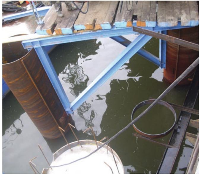
Bild 2: Einsatz des Hängegerüsts für Auflockerungsbohrungen
