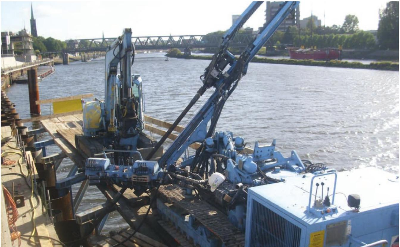
Bild 3: Hängegerüst als Arbeitsebene für Minibagger und Bohrgerät
