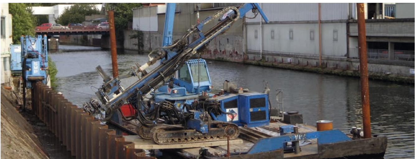
Bild 1: Wasserseitige Herstellung von GEWI-Pfählen
