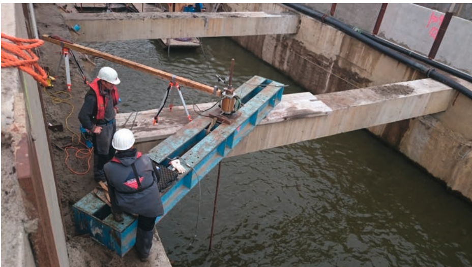
Bild 1: Abnahmeprüfung eines Auftriebspfahls in der noch offenen Trogstrecke
