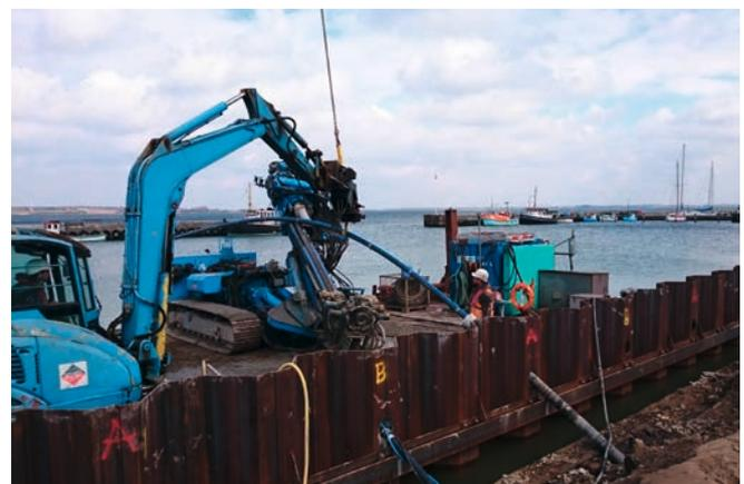
Bild 2: Landseitiger Ankereinbau mit Seilbagger
