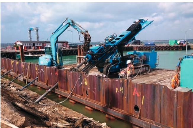
Bild 1: Ankerlochbohrung vom Arbeitsponton aus
