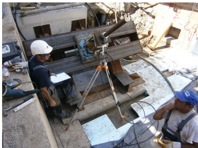
Bild 2: Probelastung an einem Zugpfahl
