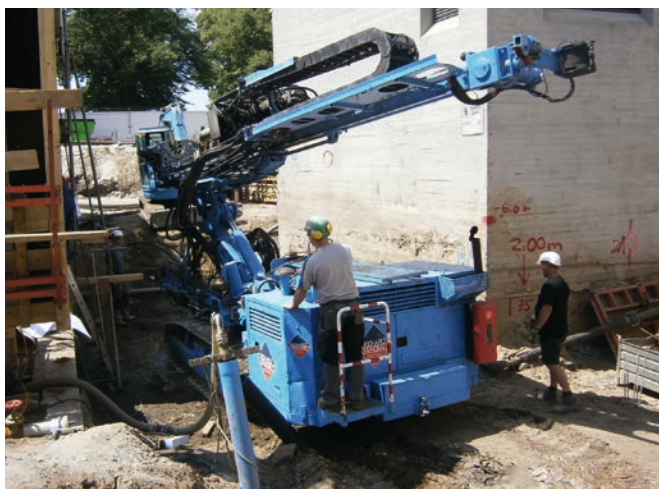
Bild 1: Rangieren des Bohrgerätes zum Bohrpunkt
