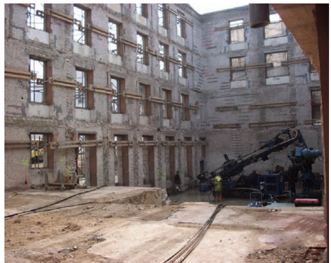
Bild 2: Einsatz mit Hilfe von zwei Bohrgeräten
