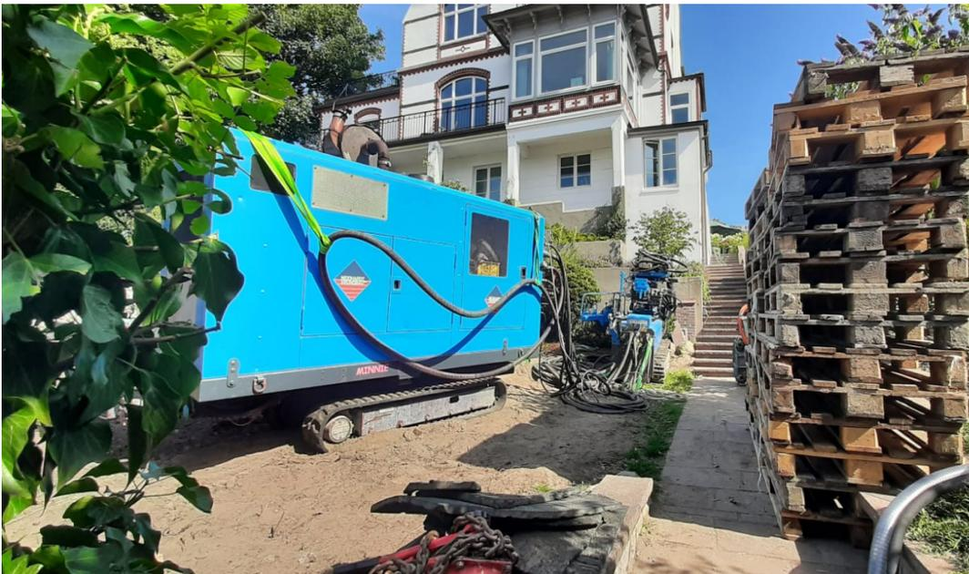
Abb. 3 Bohrgerät und Powerpack. Fotograf: Axel Noack.
