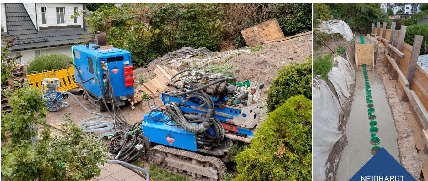
Abb. 1+2. Bohrgerät und Powerpack. Bohrschablone. Fotograf: Axel Noack.
