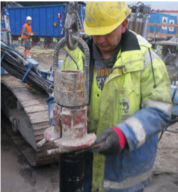
Bild 2: Anbringen der Klappmuffe an den GEWI-Pfahl
