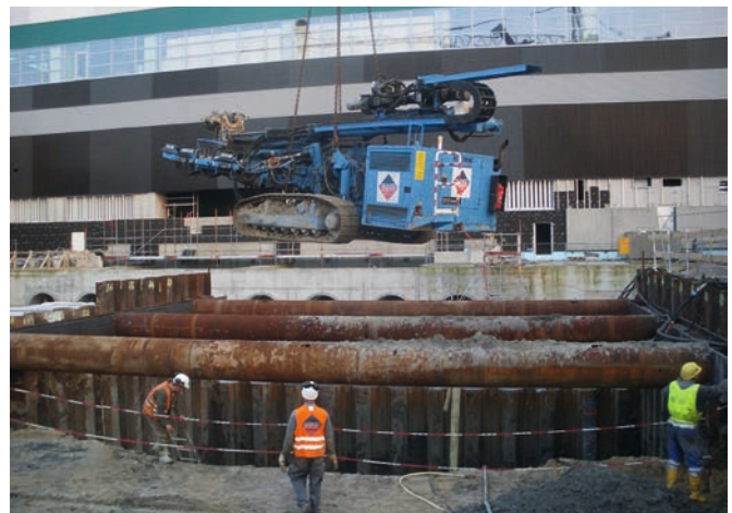
Bild 1: Einbringen unseres Bohrerätes
