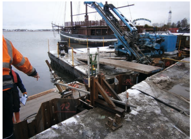
Bild 2: Herstellung sowie Prüfung der Ankerpfähle
