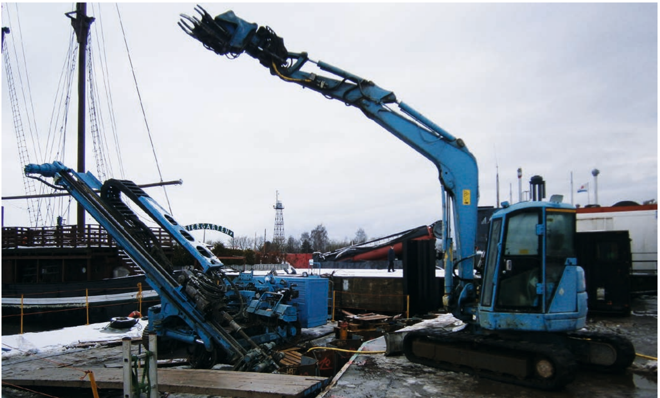
Bild 3: Kettenbagger mit Spezialgreifer zum Auflegen der Bohrröhre
