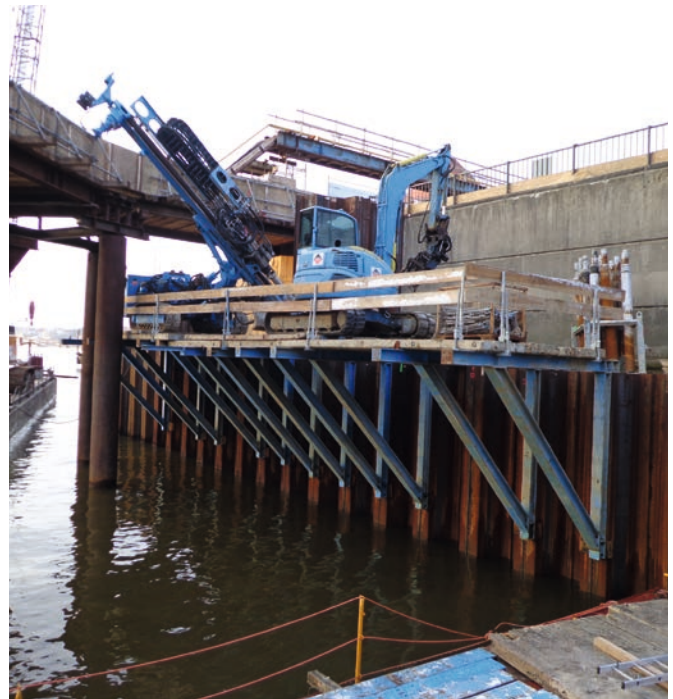
Bild 3: Bohrarbeiten auf dem Arbeitsgerüst
