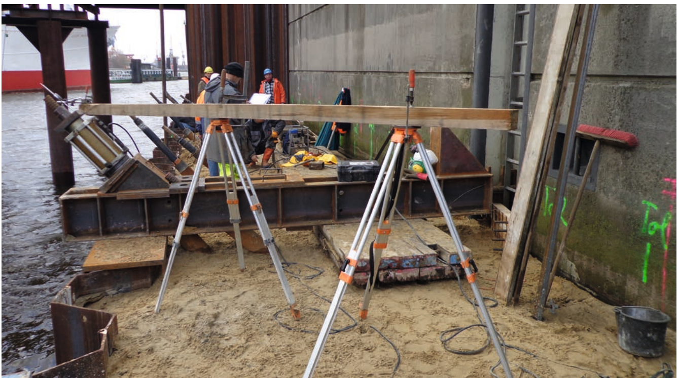
Bild 4: Abnahmeprüfung mit Hilfe einer Prüftraverse
