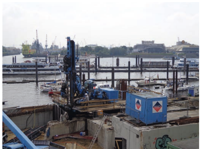
Bild 2: Bohrgerät auf Bohrbühne Sperrwerk
