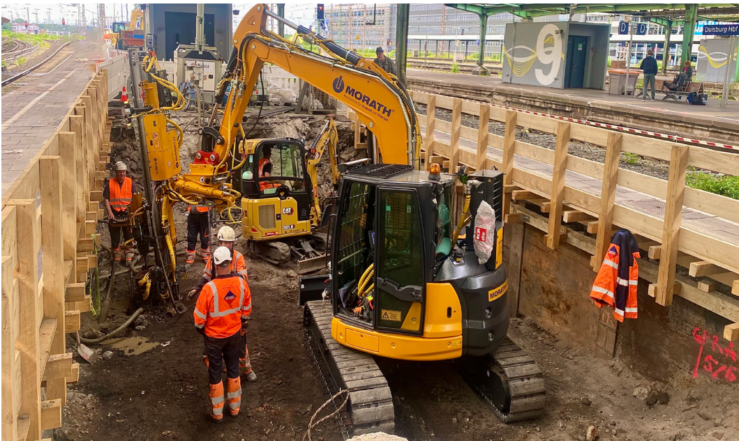
Abb. 3. Bohrbagger und Minibagger. Fotograf: Martin Fischer.
