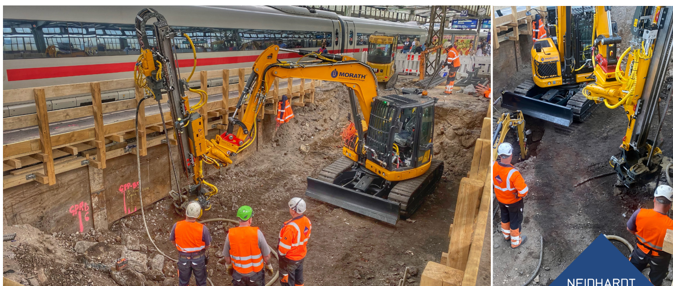
Abb. 1+2. Bohrbagger und Minibagger. Fotograf: Martin Fischer.
