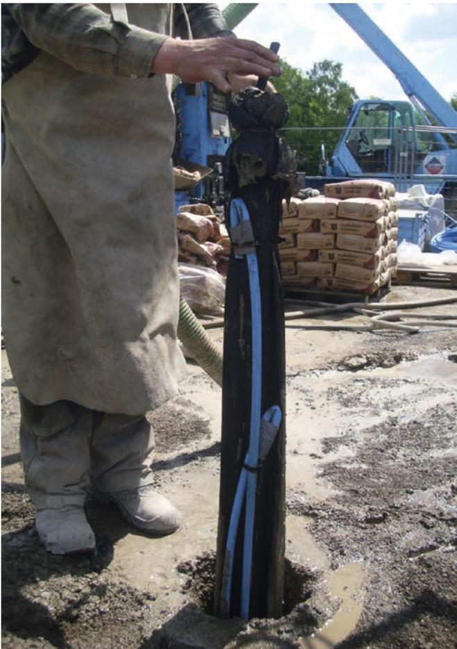
Bild 2: Nachinjektionsleitungen (blau) außerhalb und Auffüllschläuche (schwarz) innerhalb des Geotextilstrumpfes
