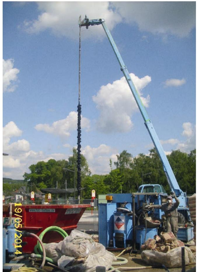
Bild 3: Einbau des Stahltraggliedes mit Geotextilstrumpf
