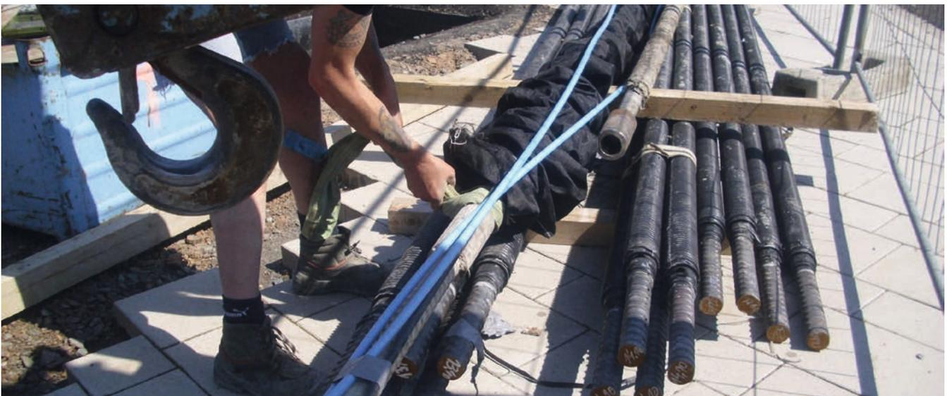
Bild 1: GEWI 50 DKS mit Geotextilstrumpf
