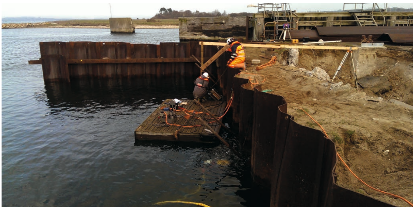
Billede 2: Vand-sidet test og forspænding af en permanent single-stang anker GEWI 57.5
