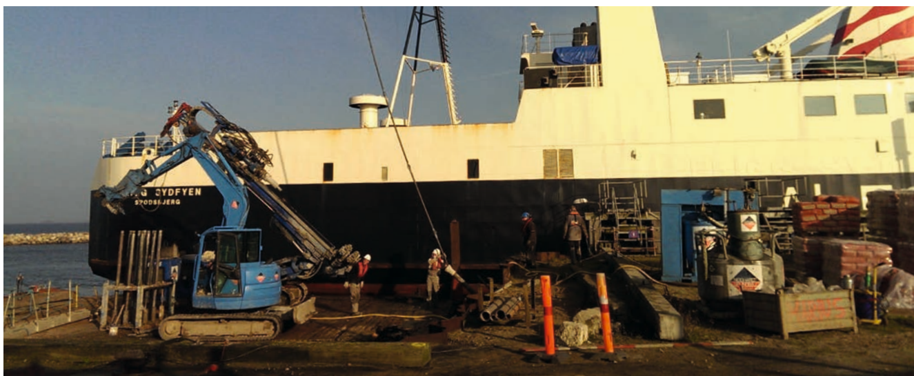
Billede 1: Installation af en 57,5 mm GEWI single-stang ankerved Bøjden ferry dock
