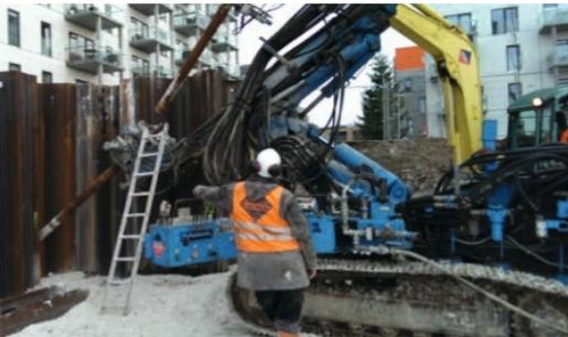
Bild 1: Bohrarbeiten im Kalkstein mittels Doppelkopfborein
