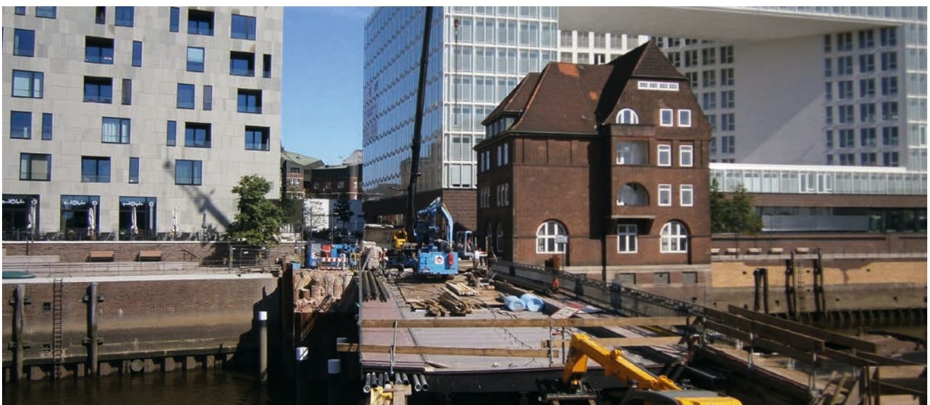
Bild 1: Blick Richtung Widerlager Nord
