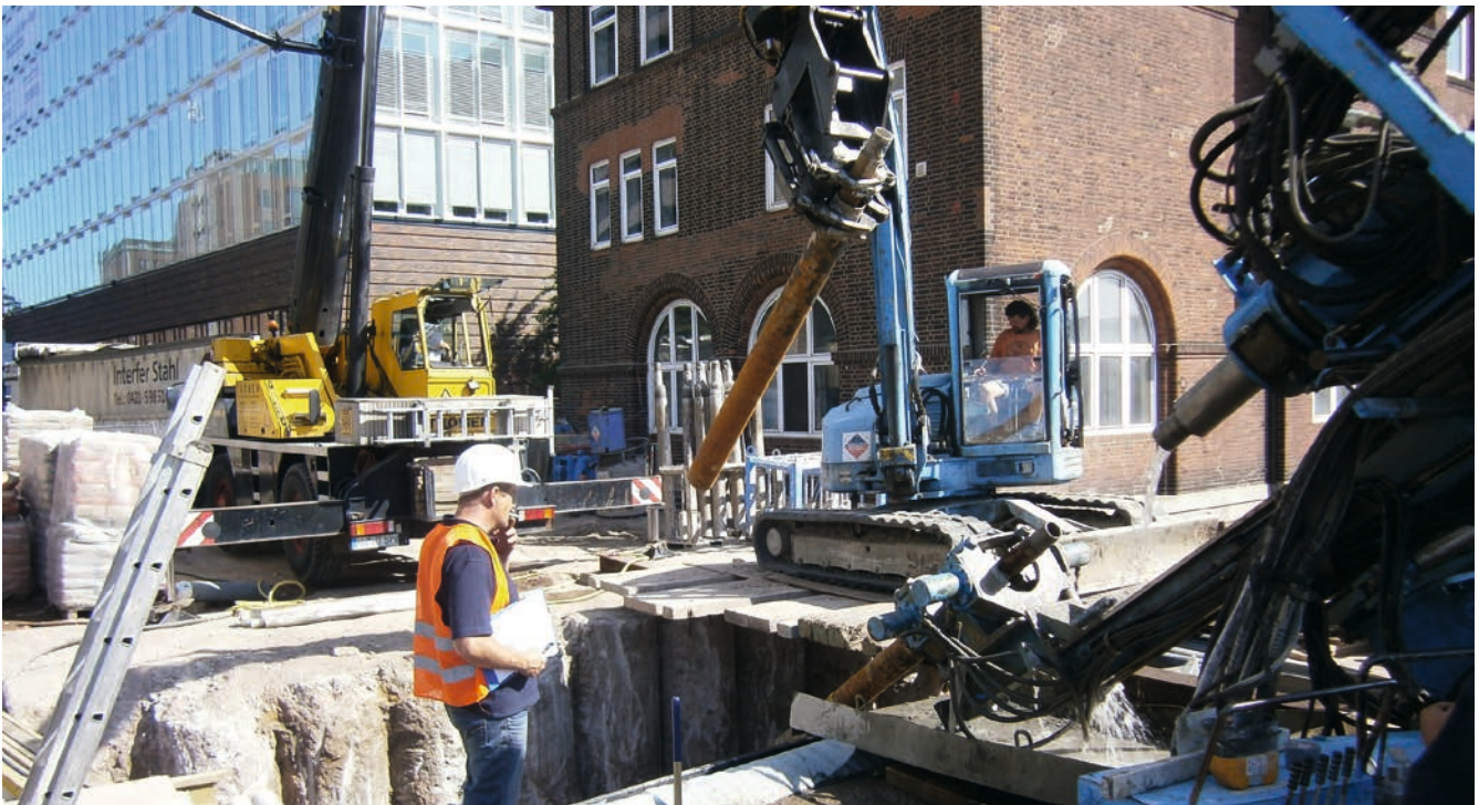
Bild 2: Bohrung der geeigneten Pfähle in die Bohrpfahlwand
