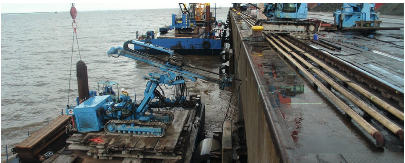
Bild 1: Bohrarbeiten auf dem Ponton
