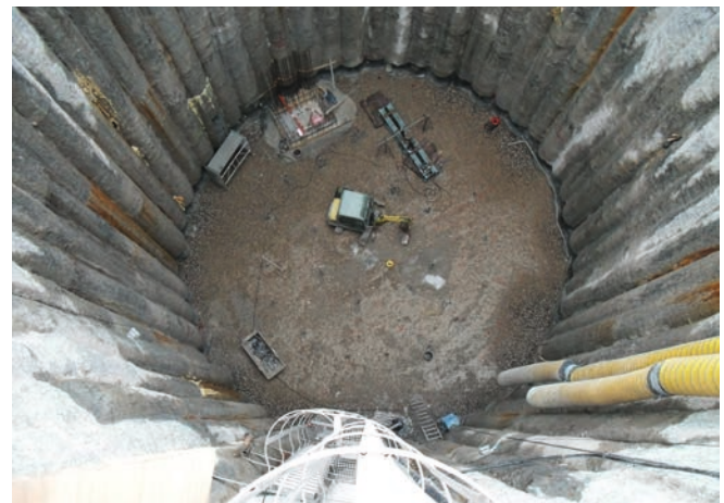
Bild 2: Baustellenansicht von oben
