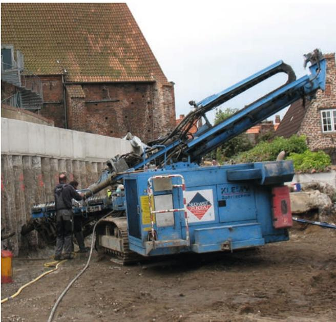
Bild 1: Herstellung geeigneter Litzendaueranker in der oberen Lage
