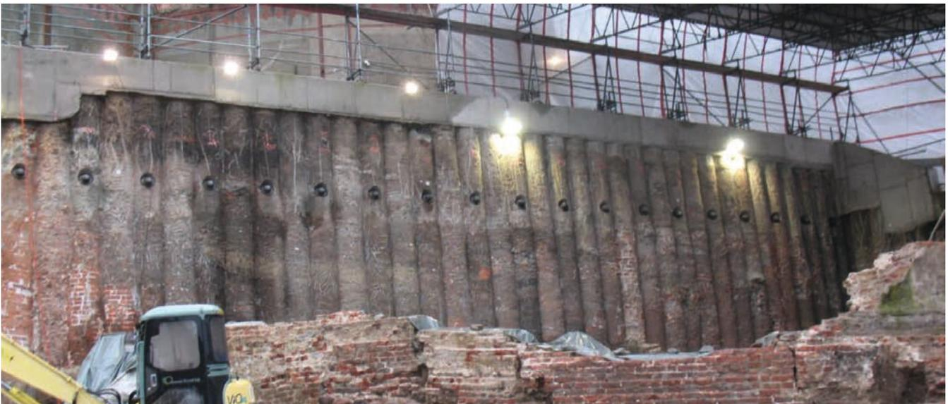
Bild 3: Ansicht der oberen Ankerlage zur Sicherung der Bohrpfahlwand
