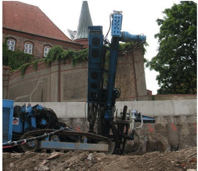
Bild 2: Ankerherstellung in unmittelbarer Nähe zum Bestandsgebäude
