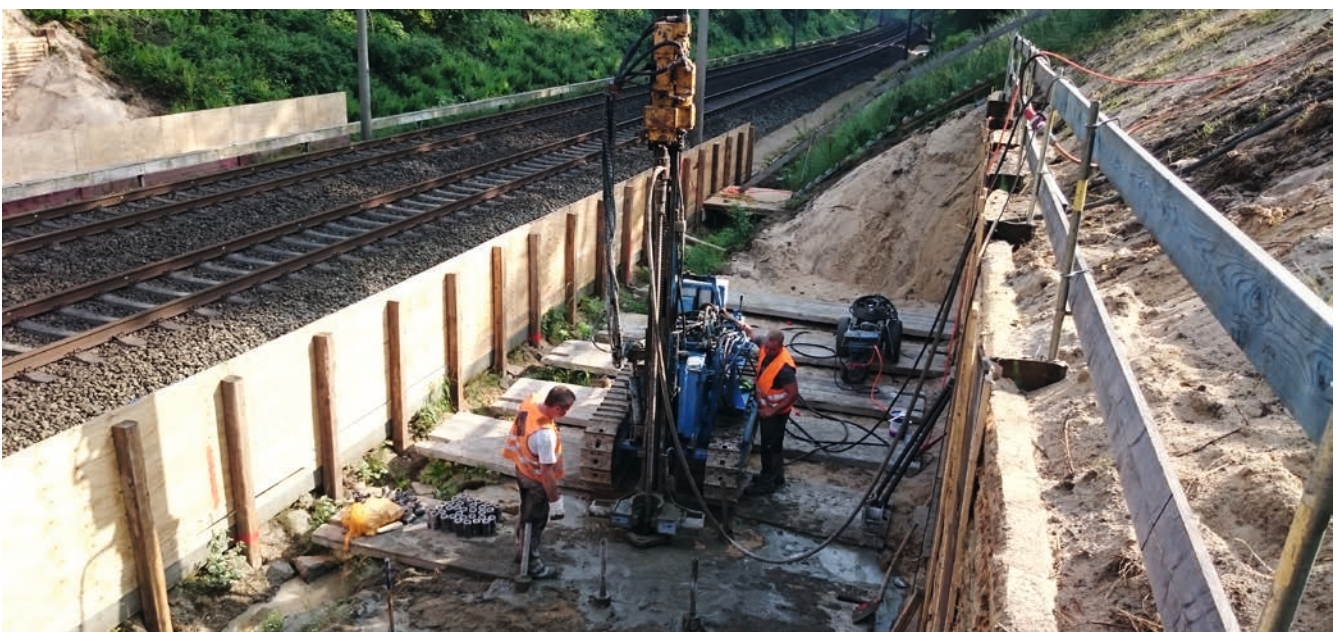
Bild 1: Beengte Verhältnisse unter laufendem Bahnbetrieb
