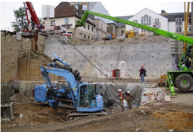
Bild 2: Einbau Gewi-Stahl
