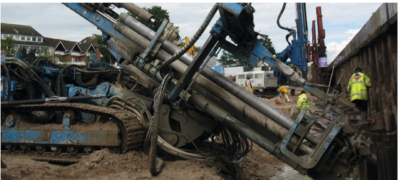
Bild 1: Ankerarbeiten im Überlagerungsbohrverfahren
