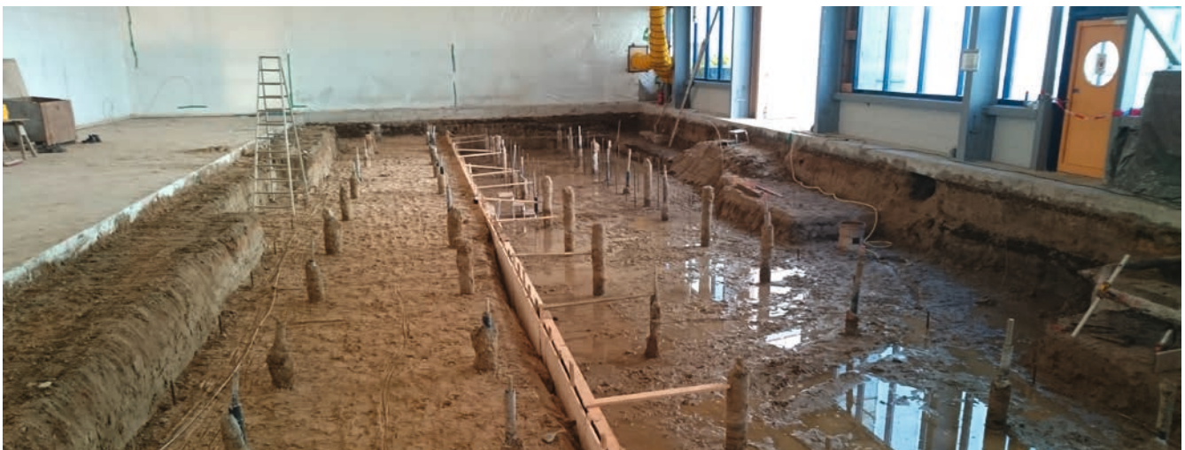
Bild 2: Mikroverpresspfähle mit Ripprohr als Gründungselemente für das Maschinenfundament
