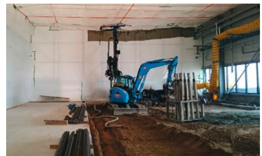
Bild 1: Baustelleneinrichtung in Halle 80
